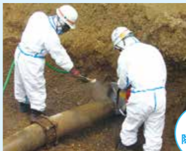
石綿管除去対策
