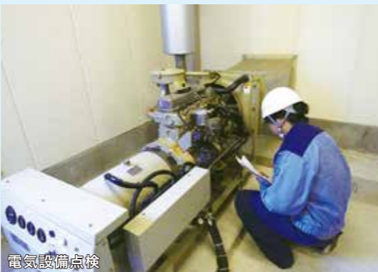
電気設備点検
