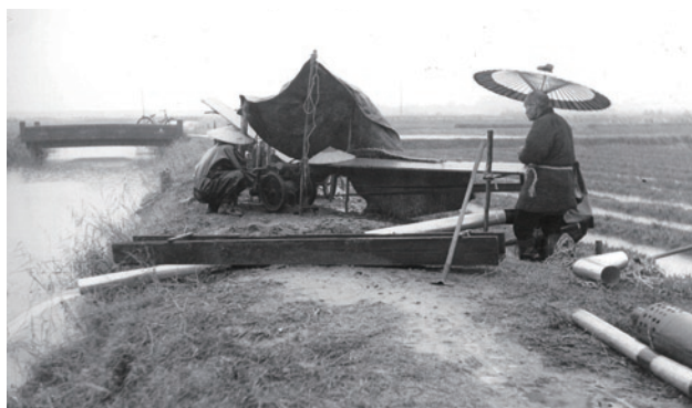
ポンプによる排水
