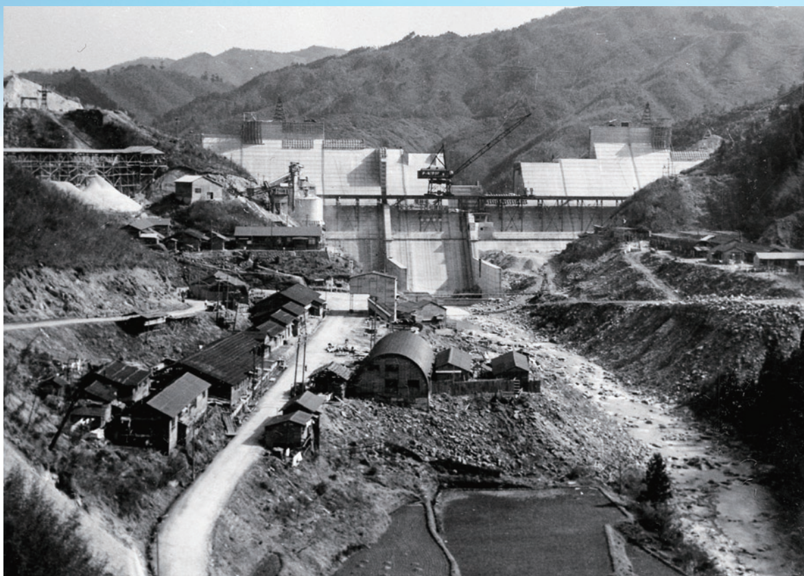
下流より羽布ダム堰堤を望む(昭和34年頃)
