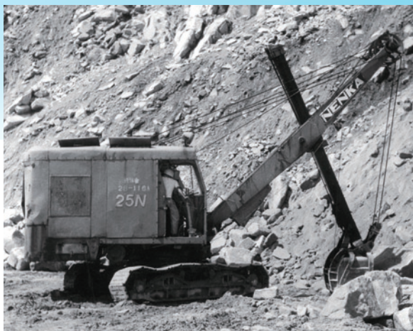
掘削作業(昭和32年頃)
