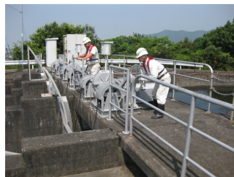
ゲート点検・操作
