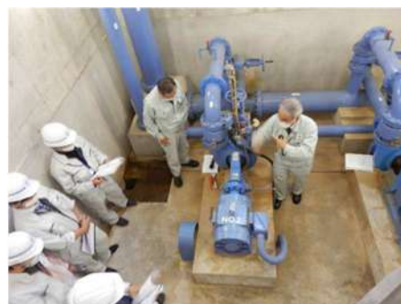
令和2年11月18日(山海揚水機場) 点検指導:(株)千代田組 中部支店
