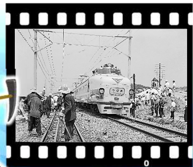
東海道線復旧工事
