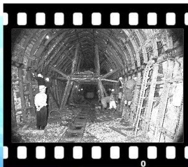
トンネル工事
